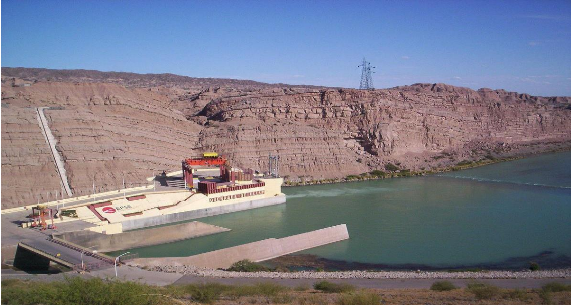
Central Hidroeléctrica a Pie de Presa Quebrada de Ullum
